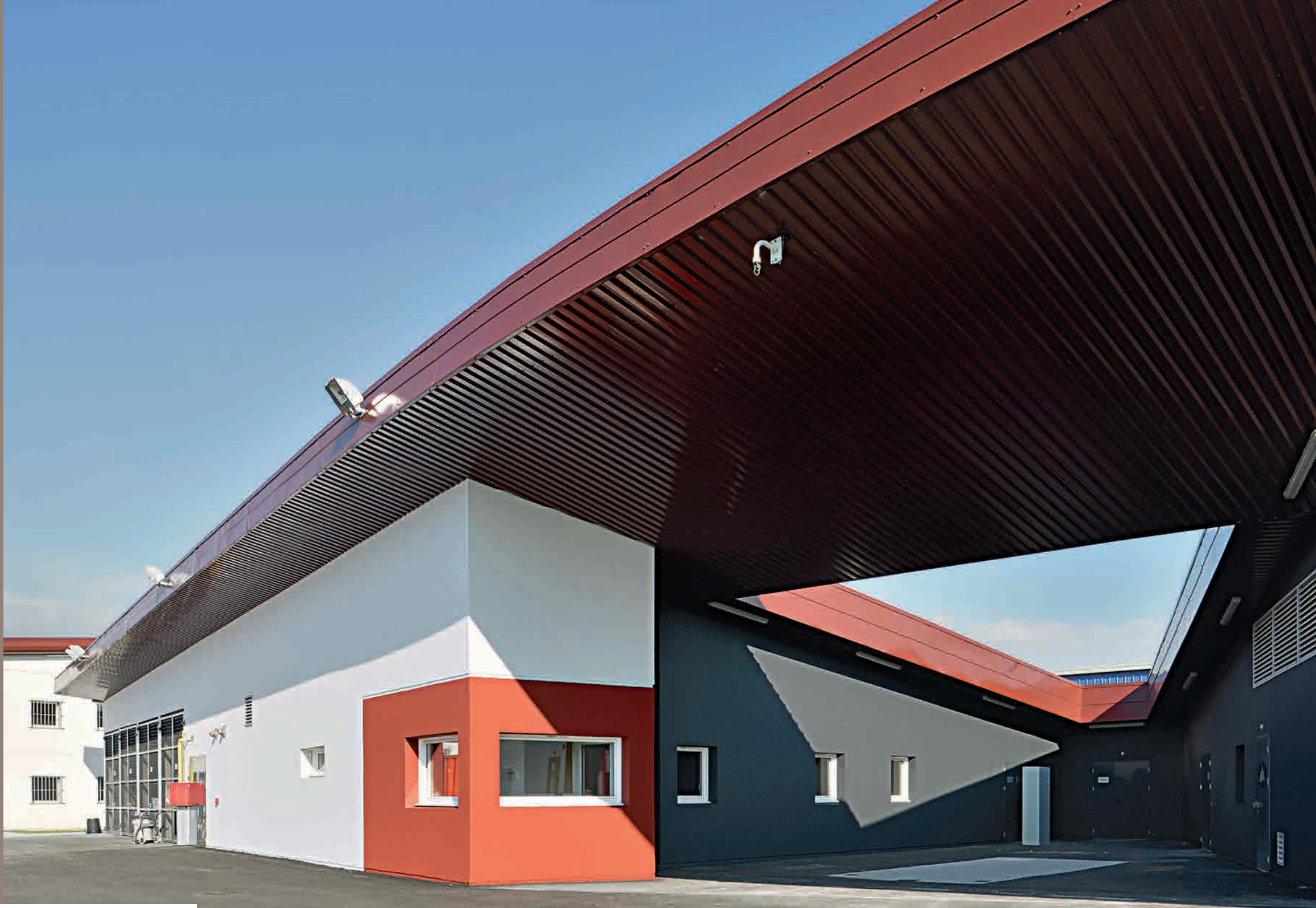
▲ Le bâtiment dédié aux services supports de l'établissement (cantine, cuisine centrale, blanchisserie, ateliers, garages, gestion des déchets).
