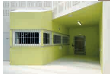
▲ Le poste de contrôle du quartier d'hébergement de la maison centrale 3.
